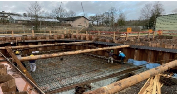
Kläranlage Püttlingen - Tragwerksplanung Verbau & Klärbecken
