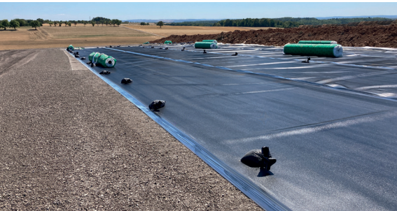
Deponiebau Fitten - KDB-Abdichtung Objektplanung, SiGeKo & Örtl.BÜ
