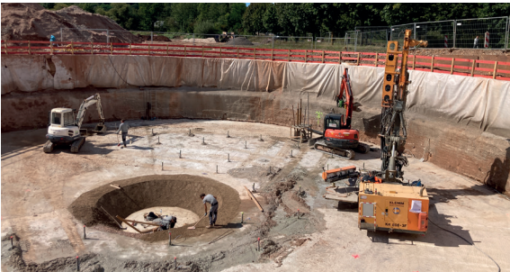
Staukanal Schmelz, RÜB 21 Tragwerks- & Objektplanung, Örtl. BÜ, SiGeKo
