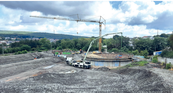
Schönungsbecken und Eindicker Camphausen Objektplanung, örtliche BÜ, SiGeKo
