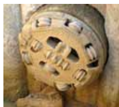
Die Bohrmaschine fährt in den Zielschacht ein.
