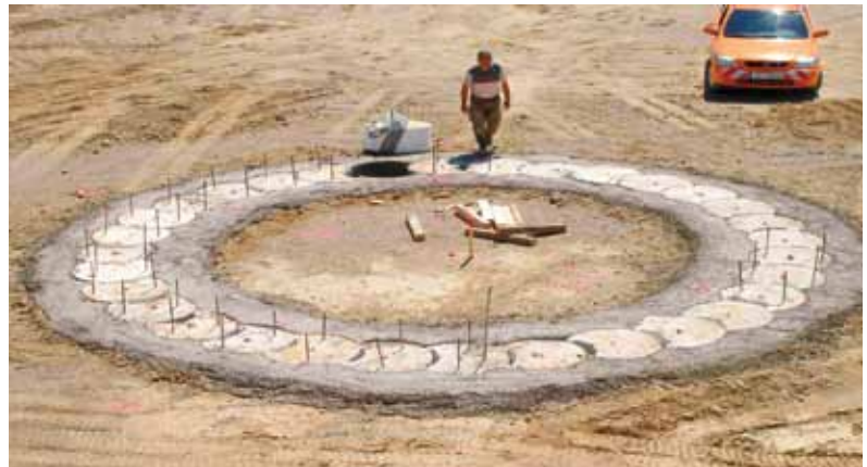
Die Bohrschablone für die Start- und Zielschächte.
